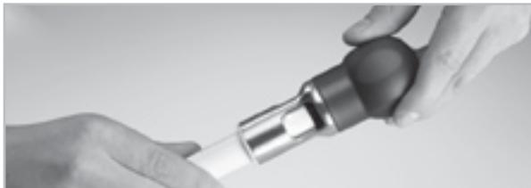
2. Rohr mit Handwerkzeug kalibrieren und entgraten. Nach 2 - 3 Umdrehungen muss eine umlaufende Fase von mindestens 1 mm sichtbar sein.
